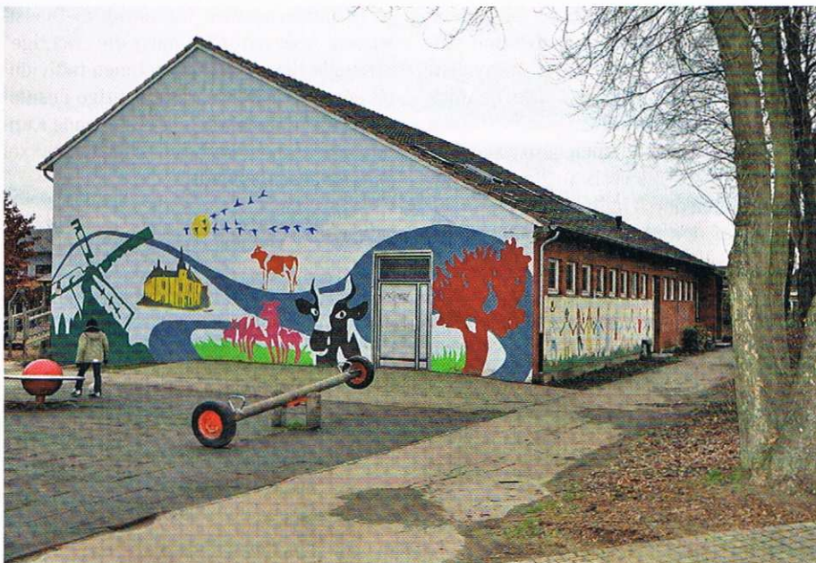
Die Sporthalle der Karl-Vogels-Grundschule in Hünxe. Für die erforderliche Trinkwasserhygiene in den sensiblen Duschbereichen sorgt eine automatisierte thermische Desinfektion der Rada-Armaturen GmbH. KRB-Haustechnik Dinslaken GmbH
