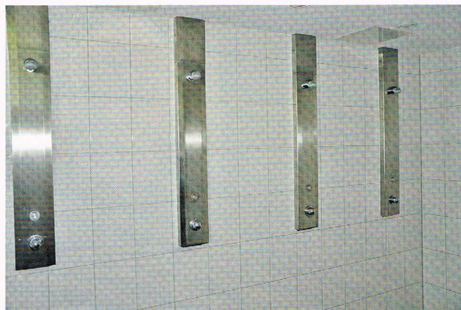
Die Rada-Systemlösung ermöglicht auch die thermische Desinfektion der kaltwasserführenden Leitungen innerhalb des Duschpanels.
